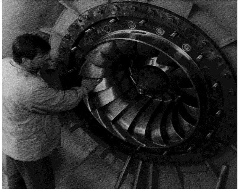
Vatnshjól í Skeiðsfossvirkjun 2
