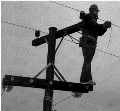
Unnið við háspennulínu. Mynd 1.30
