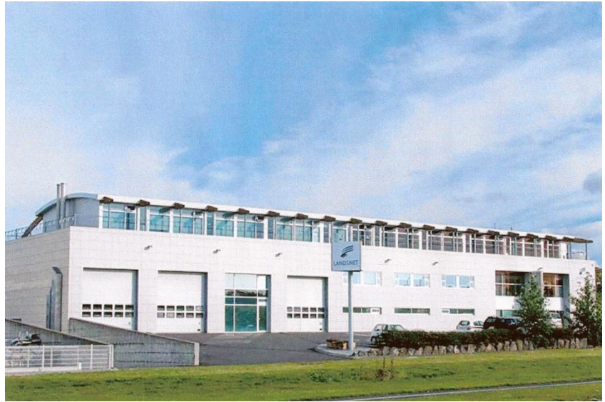
Stjórnstöð Landsnets við Gylfaflöt Mynd 1.33
