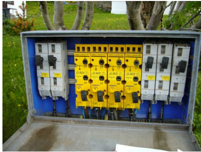
Mynd 13.1 Götuskápur með tengibúnaði fyrir fjóra notendastrengi (í miðju) og varrofum fyrir fimm heimtaugar.
